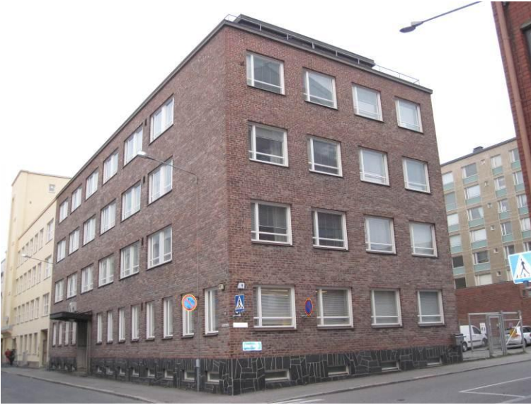
Kuvat 1 - 2. Tutkimuksen kohteena on ollut 1950 -luvulla rakennettu useampikerroksinen aiemmin kenkätehtaana toiminut rakennus.
