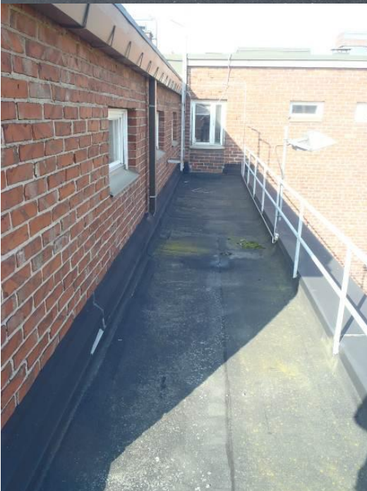
Kuvat 6 ja 7. Yleiskuvia 4. kerroksen reuna-alueilla olevasta vesikatteesta. Vesikatteet on uusitu vuonna 1990.
