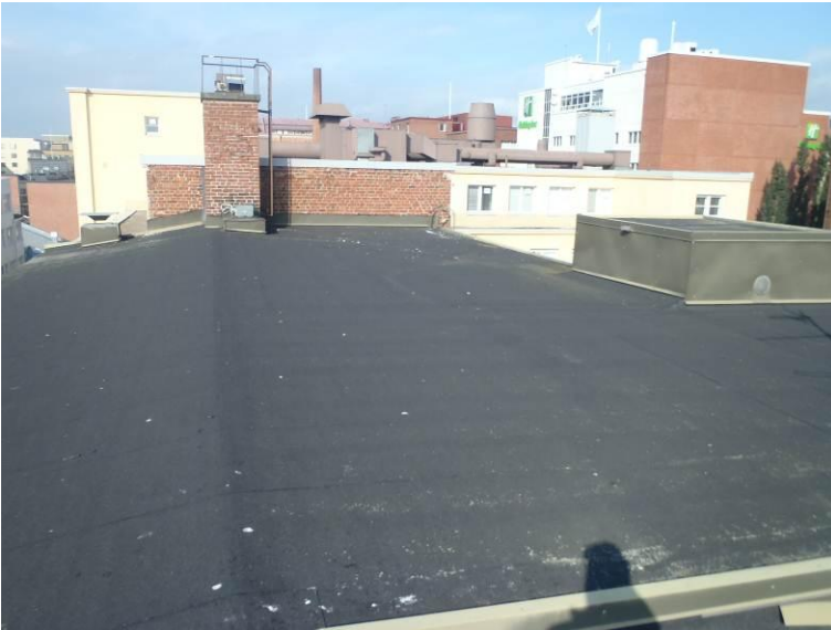
Kuva 4. Yleiskuva 5. kerroksen kohdalla olevasta vesikatteesta.
