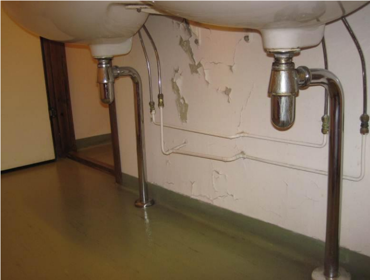
Kuva 12. Rakennuksen 2. kerroksessa wc-tilojen edustalla olevalla käytävällä lavuaarien alapuolella on havaittavissa kosteusvauriojälkiä/ maalin hilseilyä. Pintakosteusmittausten perusteella kosteusvauriokohdissa ei ollut havaittavissa poikkeavaa kosteutta.
