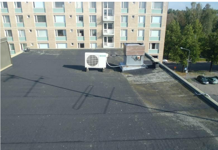
Kuva 5. Yleiskuva porrashuoneen kohdalla olevasta vesikatteesta.
